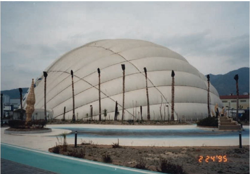
Fig. 9-14. A pneumatic dome
