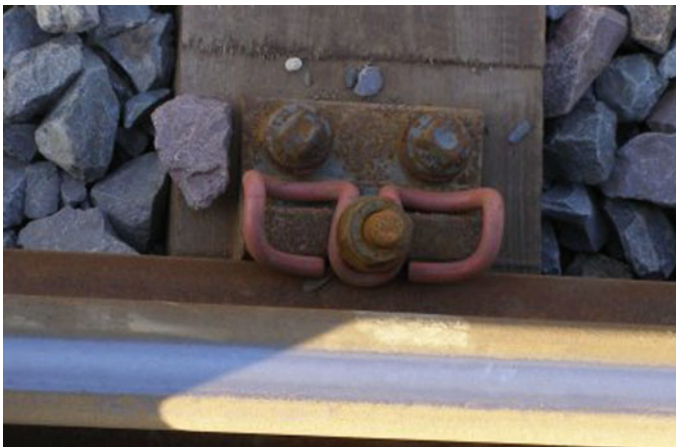
Fig. 8.3 Rail fastening of Skl-type to the wooden sleeper ( http://drogizelazne.org/obrazy/przytwierdzenie_skl_1.jpg )
