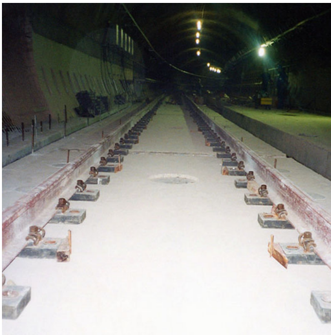
Fig. 8.7 Subway Brasilia—section Galeria dos Estados—Estação Central/Brazil (02/2001) ( http://www.gerbusa.com/index.php?id=888&no_cache=1&tx_photogals_elementid=2459&tx_photogals_image=3&MP=503-593 )
