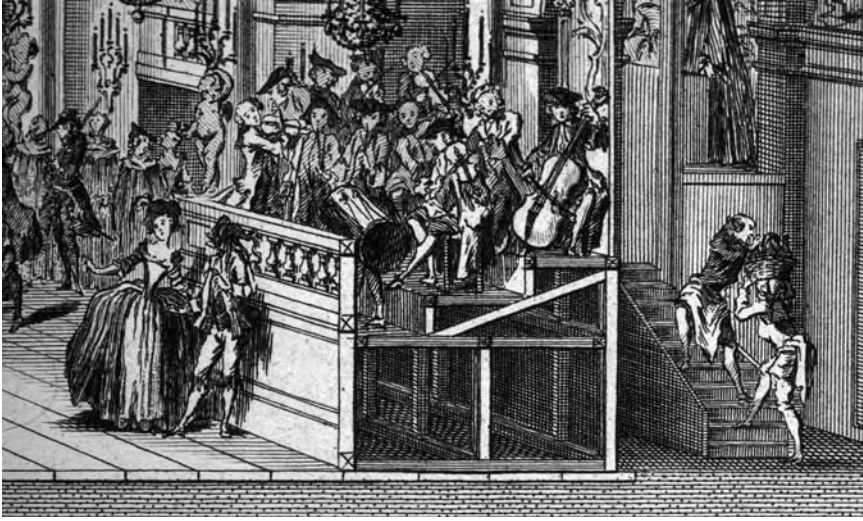
Figure 7.4 Sectional drawing showing the structure of a tiered orchestra stand installed in the courtyard of the Hôtel de Ville in Paris on the occasion of the marriage of Madame Première in 1739. Detail, taken from Description des fêtes données par la Ville de Paris à l'occasion du mariage de Madame Louise-Isabelle de France et de Dom Philippe, Infant & Grand Amiral d'Espagne, les 29 et 30 août 1739 , (1740) Paris: Mercier. Musée départemental Dobrée, Nantes, Inv. Imprimé 1372. Cliché Ch. Hémon - Musée départemental Dobrée, Conseil général de Loire-Atlantique-Nantes.
