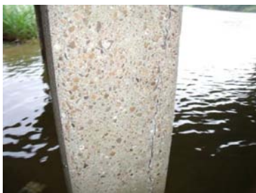
(d) Column with visible vertical cracking
