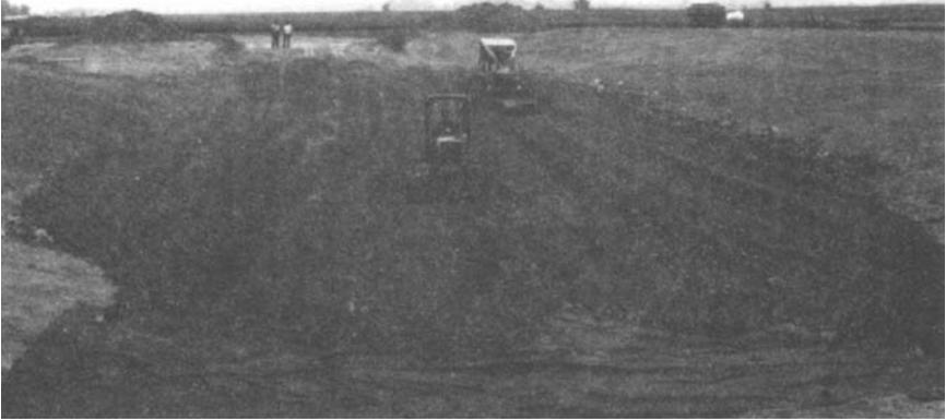
*FIGURE 6-10. Spreading the FGD Material.*
