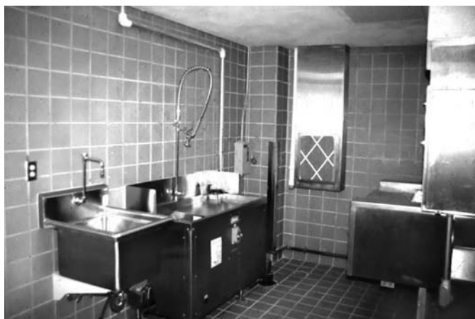
Fig. 31-10 Bedding disposal unit.
