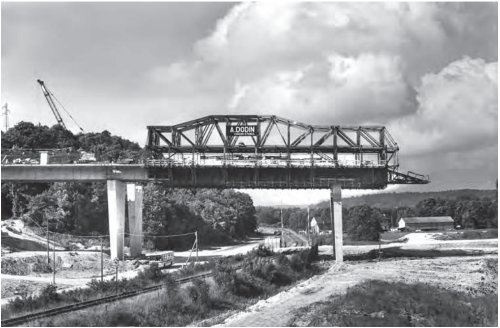
Figure 12.3 Viaduc d'Incarville, Autoroute de Normandie: self-launching rig (Photo Robert Benaim)
