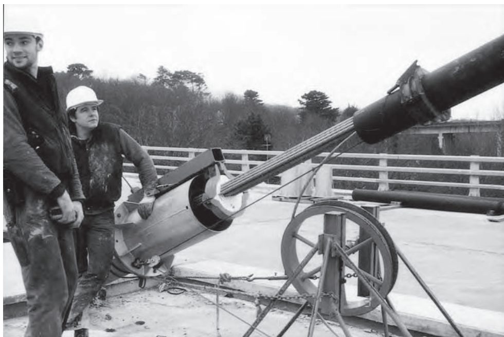
Figure 18.17 Pont sur l'Elorn: stay cable erection (Photo: Robert Benaim)
