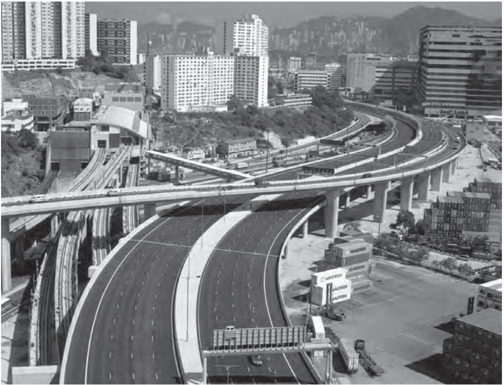
Figure 10.6 Kwai Chung Viaduct (Photo: Phototèque VINCI et filiales)
