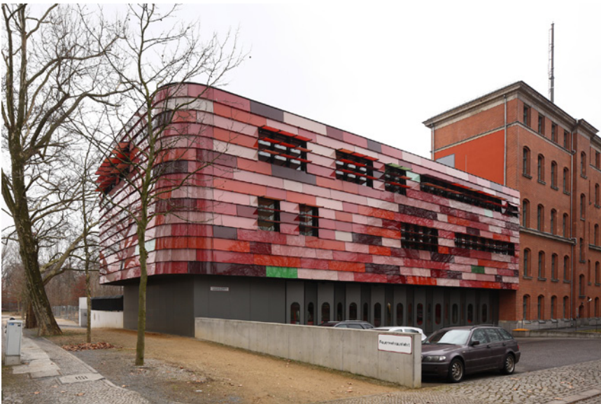
Figure 8.3 Feuerwache Regierungsviertel (exterior), Berlin, Germany. Photograph provided courtesy of Oliver Schäffler.
