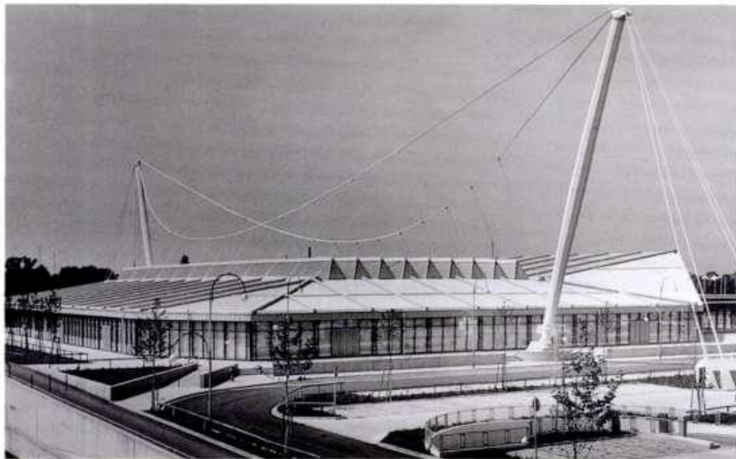
10.11 The Europahalle in Karlsruhe
