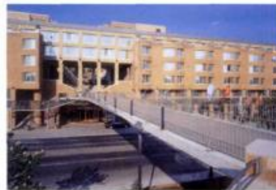
The Neckarstraße footbridge
