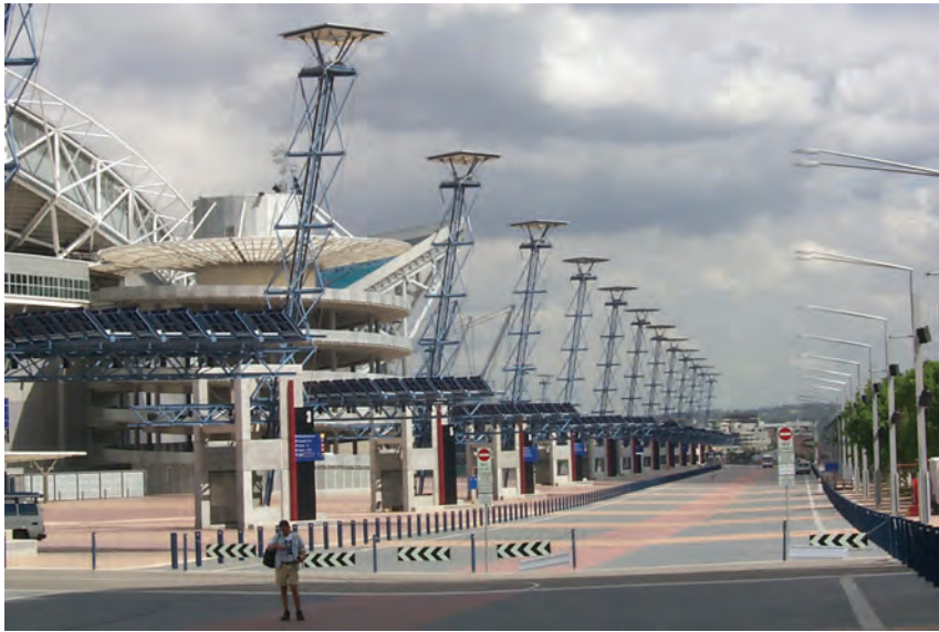
PV pylon boulevard
