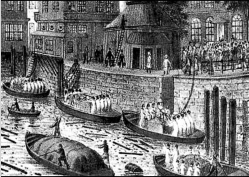
Figure 10.2. Fire brigade fighting from the canals. (Reproduced from Kulturbehörde Hamburg, Denkmalschutzamt, Museumspädagogischer Dienst, Wasser für Hamburg: Zur Geschichte der Hamburger Wasserversorgung und -entsorgung [Hamburg: Dölling and Galitz, 1992], 28.)
