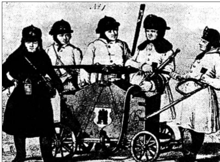
Figure 10.1. Equipment and portable pumps of the fire brigade. (Reproduced from Kulturbehörde Hamburg, Denkmalschutzamt, Museumspädagogischer Dienst, Wasser für Hamburg: Zur Geschichte der Hamburger Wasserversorgung und -entsorgung [Hamburg: Dölling & Galitz, 1992], 31.)
