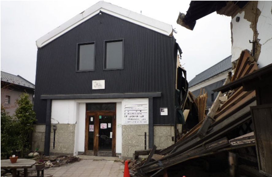
Fig. 3.8 Retrofitted storehouse in Osaki
