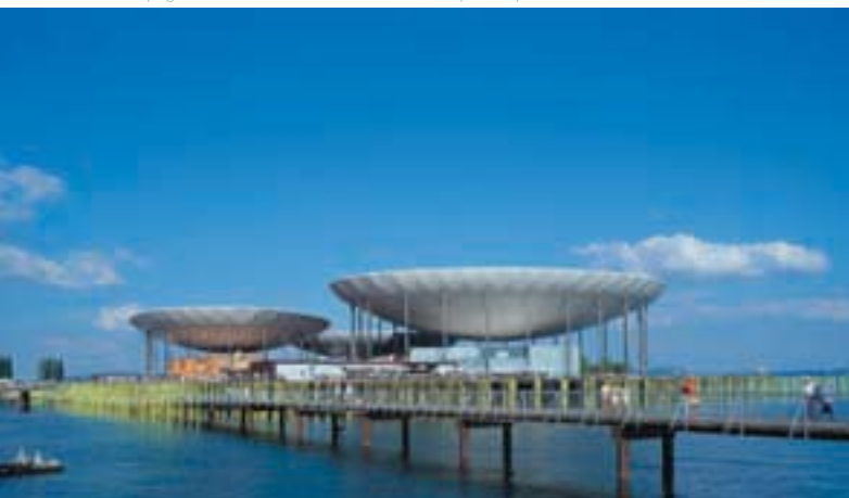
Arteplage, Neuchatel, Switzerland. Architect: Groupe Multipac.
