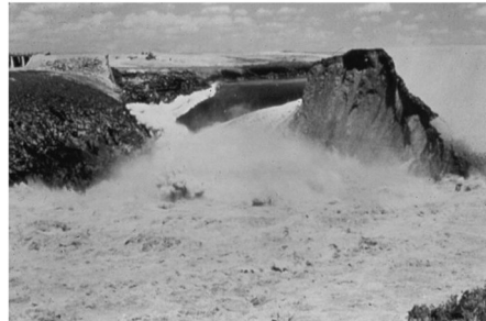
(d) Dam breached early afternoon
